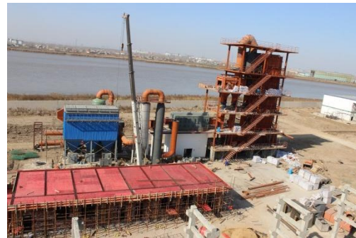
正在建设的三合一焚烧炉
