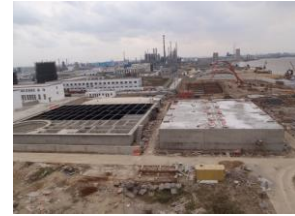
建设中的盐城联化废水一期项目
